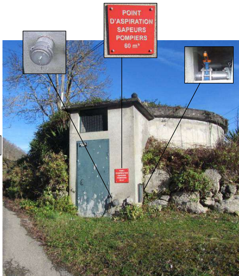
Réservoir AEP avec prise directe en DN100 branchée sur la vidange avec vanne quart de tour à manœuvrer
