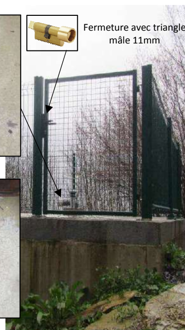
Portillon accès pour le remplissage
