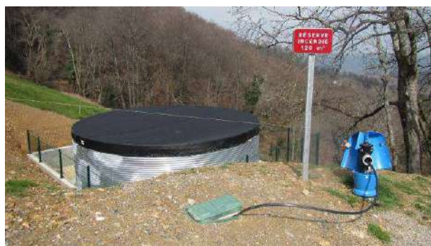
Réserve 120 m 3 avec PA de type S et remplissage depuis le réseau d'eau
